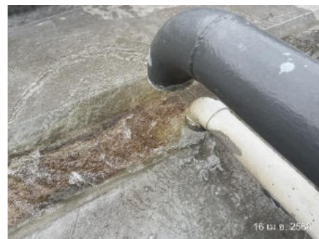
(3) จุดท่อน้ำทิ้งจากห่อฝึ่งเย็นแต่ละเครื่อง
